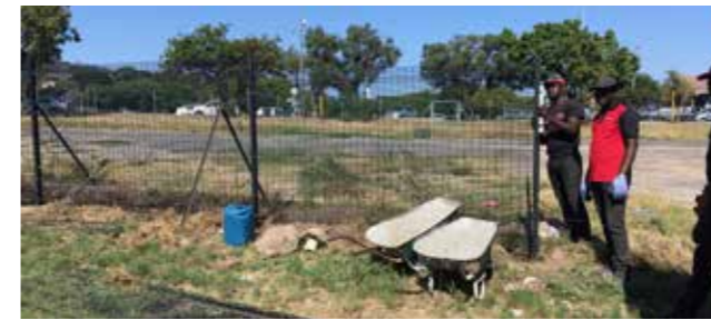
Der neue Zaun wird Stück um Stück eingesetzt.
